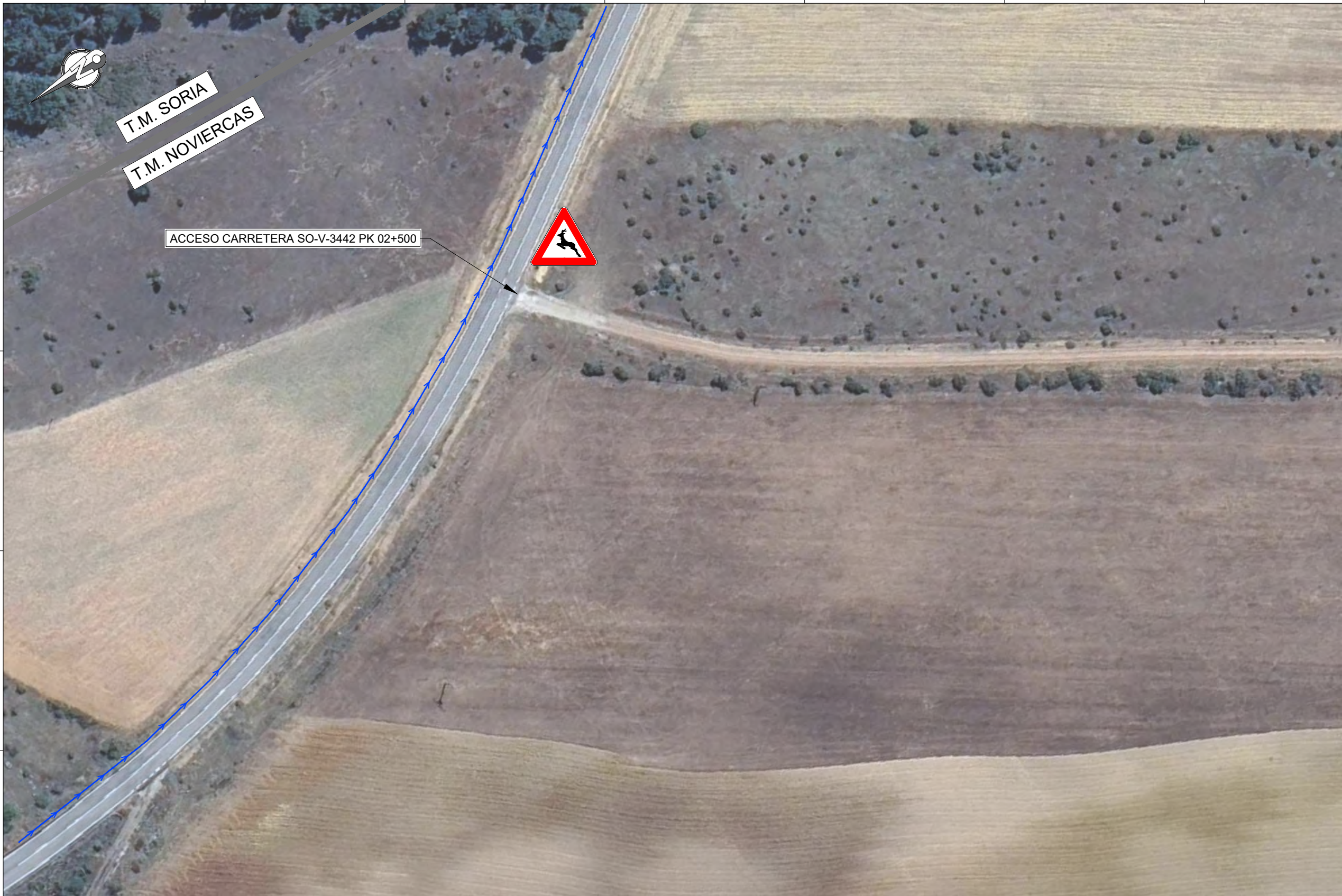
ENTRONQUE (CARRETERA SO-V-3442) ESTADO ACTUAL
